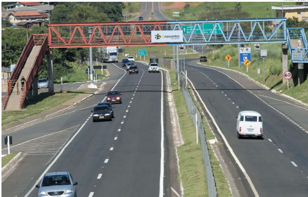
Foto arquivo do "JS" da MGC 491 já na área urbana de Paraíso, rodovia que por falta de manutenção está com verdadeiras crateras no trecho do município paraísense até Monte Santo de Minas
