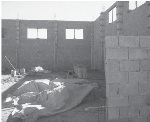
Construção da sede da Associação RENASCR
