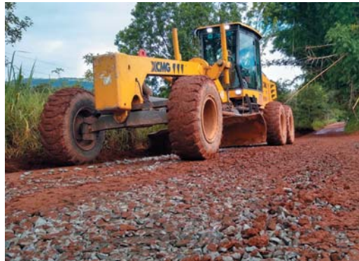
Máquinas da Prefeitura estão trabalhando para o melhoramento e recuperação nas estradas rurais
