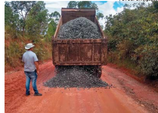
Para evitar encravamentos, pedras britas estão sendo colocadas em trechos críticos
