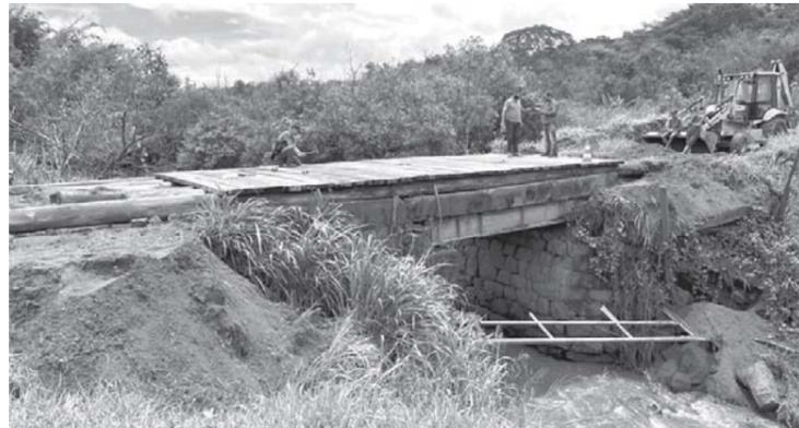
A estrutura havia sido afetada pelo intenso volume de água, que causou erosão no local, ocasionando também trincas em diversos pontos da estrutura que sustenta a ponte. Conforme destaca o prefeito Marcelo Moraes, foi um
