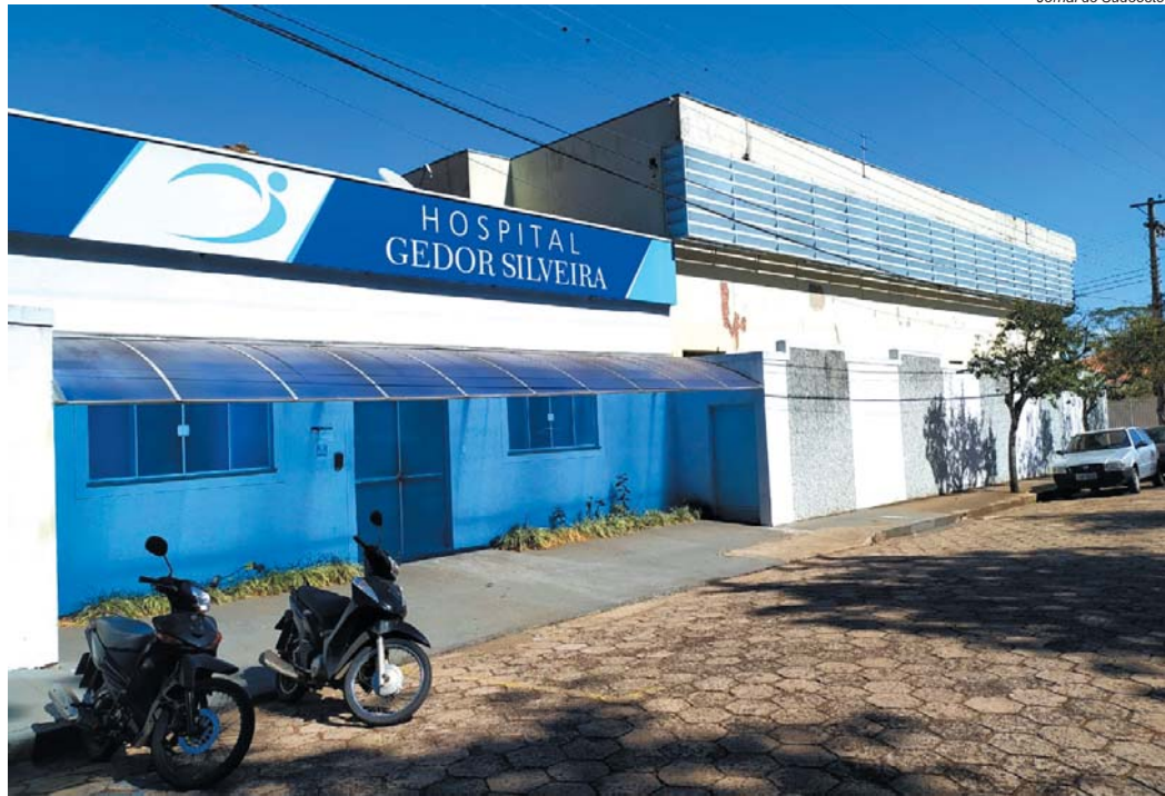
Em ofício alarmante, a curadoria do hospital solicita apoio urgente das autoridades e revela déficit mensal de R$ 300 mil
