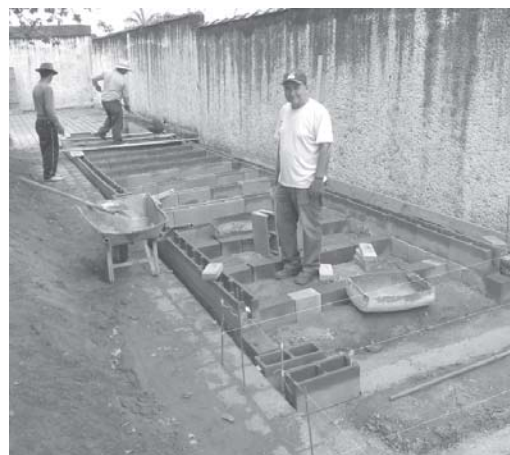
Construção dos Ossuários Perpétuos vão receber ossadas de pessoas sepultadas no Cemitério Ecológico Memorial da Saudade. Na foto o pedreiro e coveiro, Benedito Rustiguelli
