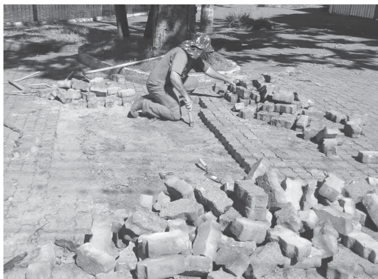
Calceteiro trabalhando na reforma do calçamento em torno da Praça Santa Paula Frassinetti, Lagoinha
