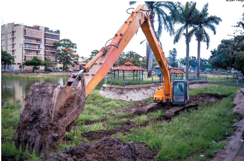
Serviço de desassoreamento deve levar 20 dias. Lagoas do San Genaro também serão revitalizadas
