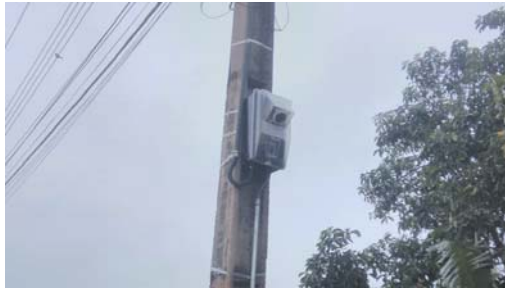
A caixa do padrão para colocar o relógio para registrar o consumo de energia elétrica das luminárias da passarela já está pronto
