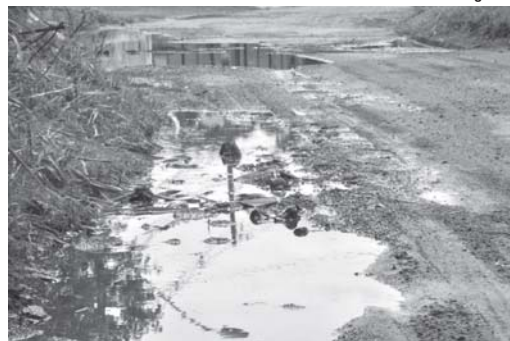
Trecho foi fechado por entupimento de galeria que forma poças de água na via lateral podendo provocar acidentes
