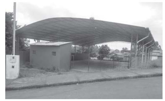
Quadra coberta Poliesportiva no Bairro São Francisco, obra concluída, inclusive com iluminação artificial para realizar jogos durante a noite
