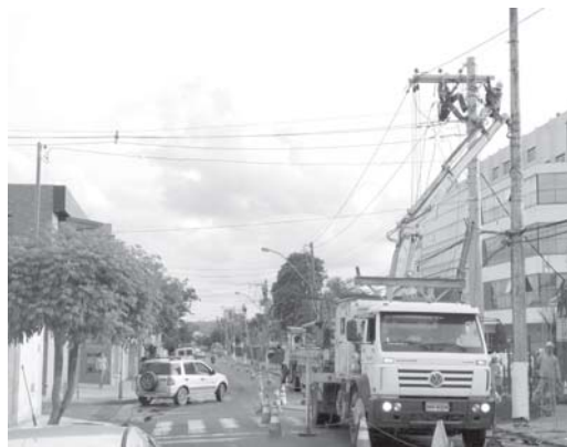
Cemig substitui postes com problemas de estrutura por postes novos e mais seguros
