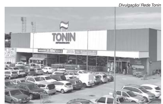
Uso da energia limpa nas lojas da Rede Tonin fez com que a empresa deixasse de emitir 6.470,4 toneladas de CO2 na atmosfera
