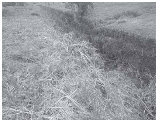
Limpeza inadequada deixa o leito da canalização do Córrego Coolapa ainda bastante sujo
