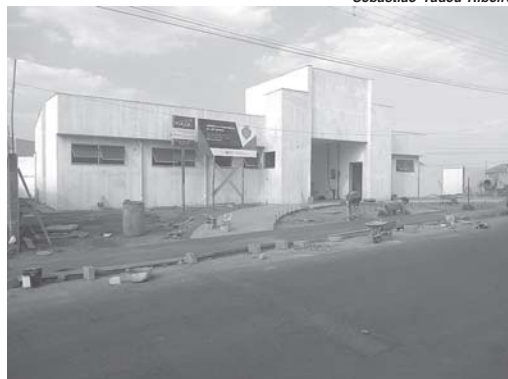
Conclusão da obra da UBS do Bairro Verona, está em fase de acabamento
