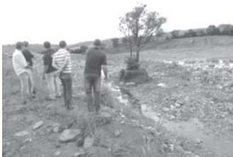
Vereadores estiveram pela terceira vez no aterro sanitário e constatou continuidade das irregularidades
