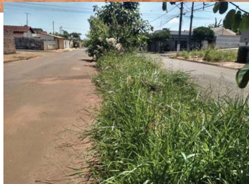
Av. Manoel Cândido Filho, no entroncamento com Av. Isoleta Maria de Avelar Provenzano, no Residencial Vila Verde, vejam o tamanho da cratera e matos no canteiro central
