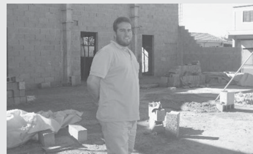
Neilson, presidente da RENASCEM em frente a Construção da sede da RENASCEM
