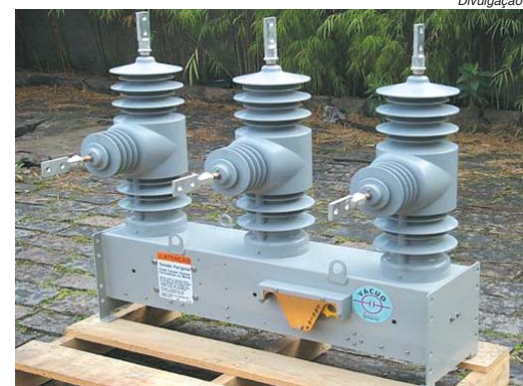
Equipamentos estão sendo instalados na zona rural de vários municípios da região
