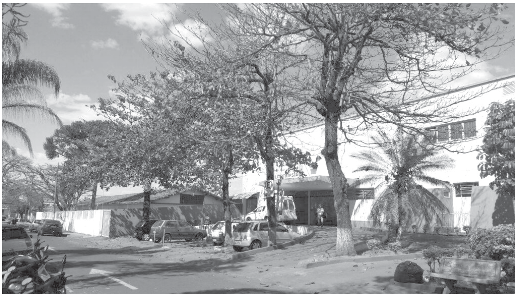
Pedido seria para análise de árvores pareadas com o Hospital e que estariam danificando a estrutura do prédio e acessibilidade de pacientes
