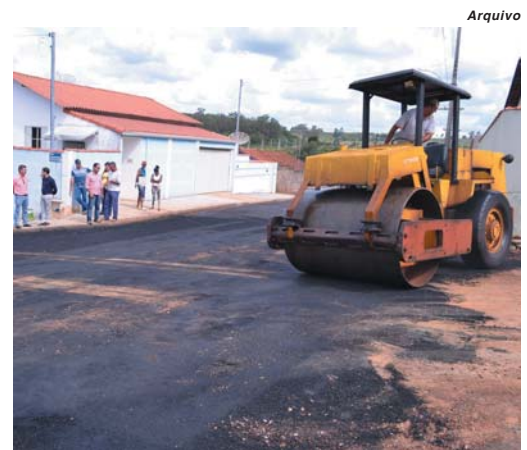
Programa prevê obras de melhorias nas ruas da cidade com recapeamento de vias
