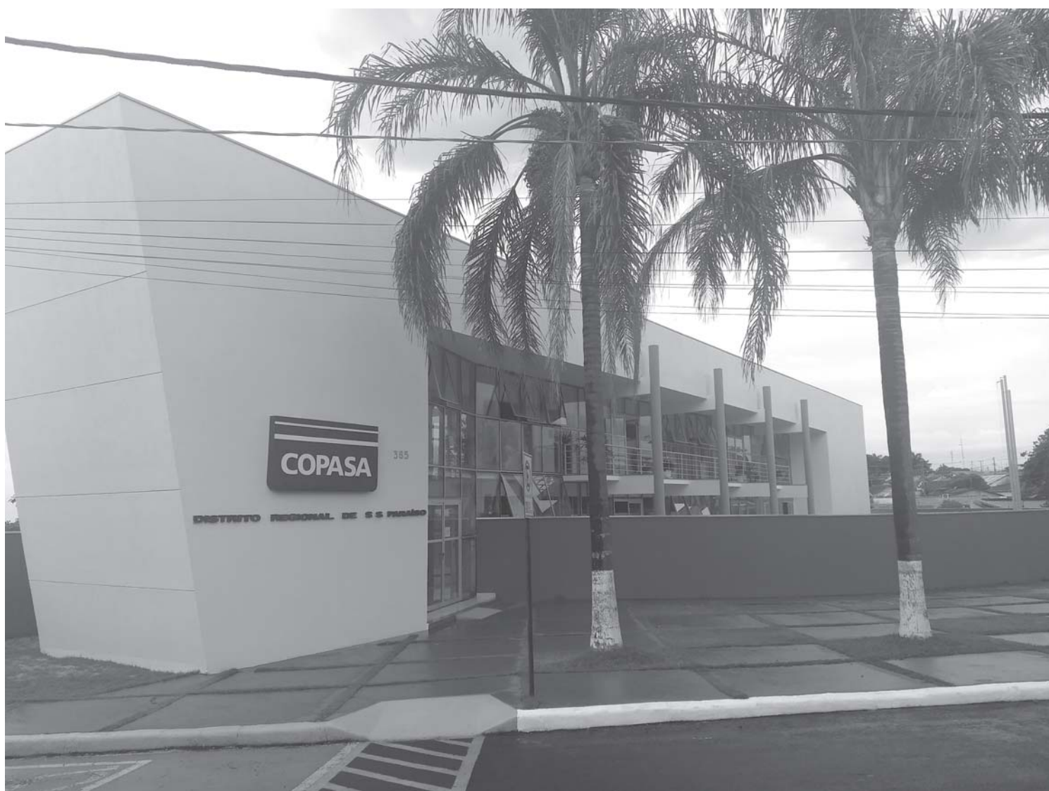
Com ETEs finalizadas, Copasa hoje realiza o tratamento de 53% do esgoto coletado na cidade
