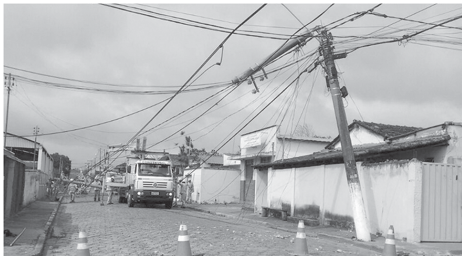
No São Judas um pinheiro caiu sobre a rede de energia vindo a derrubar um poste que não suportou o peso da árvore
