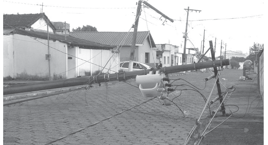
No São Judas um pinheiro caiu sobre a rede de energia vindo a derrubar um poste que não suportou o peso da árvore
