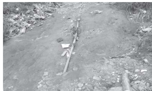
Erosão provocada pela chuva danificou tubulação de água pluvial no Alto Bela Vista
