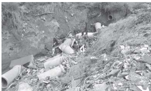
Erosão provocada pela chuva danificou tubulação de água pluvial no Alto Bela Vista
