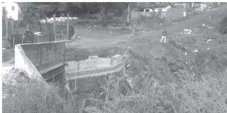
Ponte da Rua Dona Otília Amaral está sendo reformada na estrutura de sua base e as laterais. Sentido São Tomás de Aquino-São Sebastião do Paraíso.
