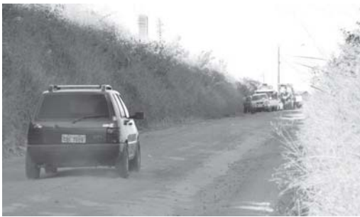
Obras realizadas a serviço de operadora de internet para instalação de rede trouxe perigo para o trecho
