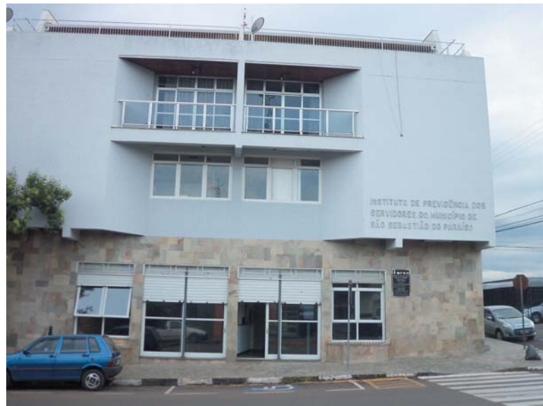
Instituto de Previdência dos Servidores do Município - INPAR
