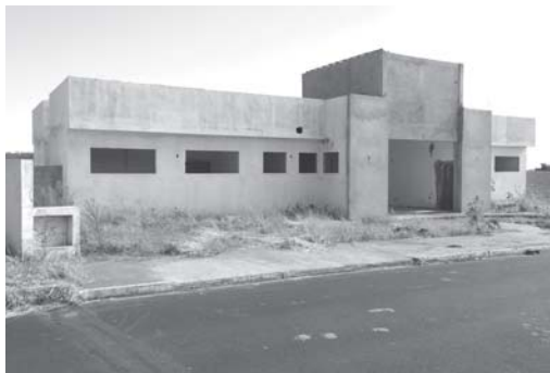
Obra inacabada e paralisada da UBS no Bairro Rosentina 2
