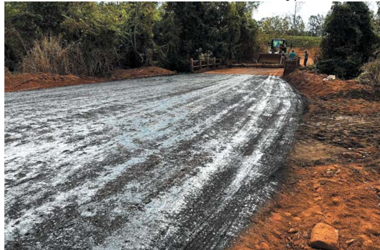
Ponte será construída em 2024, pois, obras dependem de autorização de órgãos ambientais
