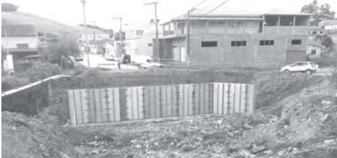
PONTE SOBRE O RIBEIRÃO SÃO PEDRO
