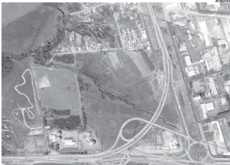
Projeto de construção da interligação entre a MG-050 e BR-491 foi anunciado em 2010
