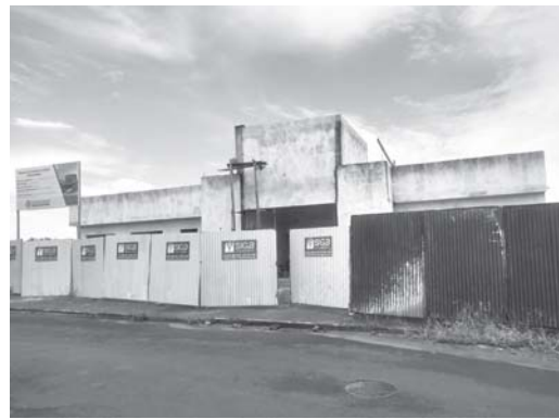
O prédio da Unidade Básica de Saúde no Rosentina 2, os serviços para o término da obra inacabada está em ritmo lento
