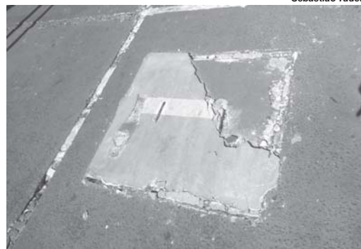
Tampa de caixa de concreto de frente para o Banco Itaú, está fragilizada oferecendo riscos de acidentes com pedestres
