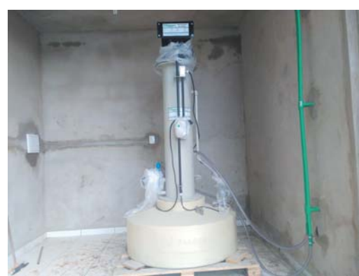
Filtro que desidrata e evapora o necrochorume assim que ele é gerado
