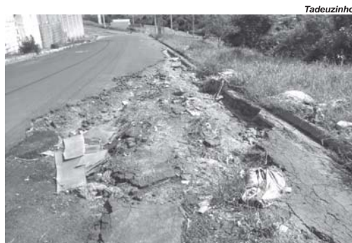
Cratera provocada por enxurradas e boca de lobo insuficiente, e entupida de matos, na Rua Alexandre Colozzi, no Parque Belvedere
