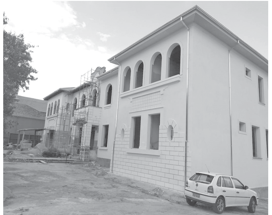
O prédio antigo do Instituto Monsenhor Felipe está sendo totalmente restaurado
