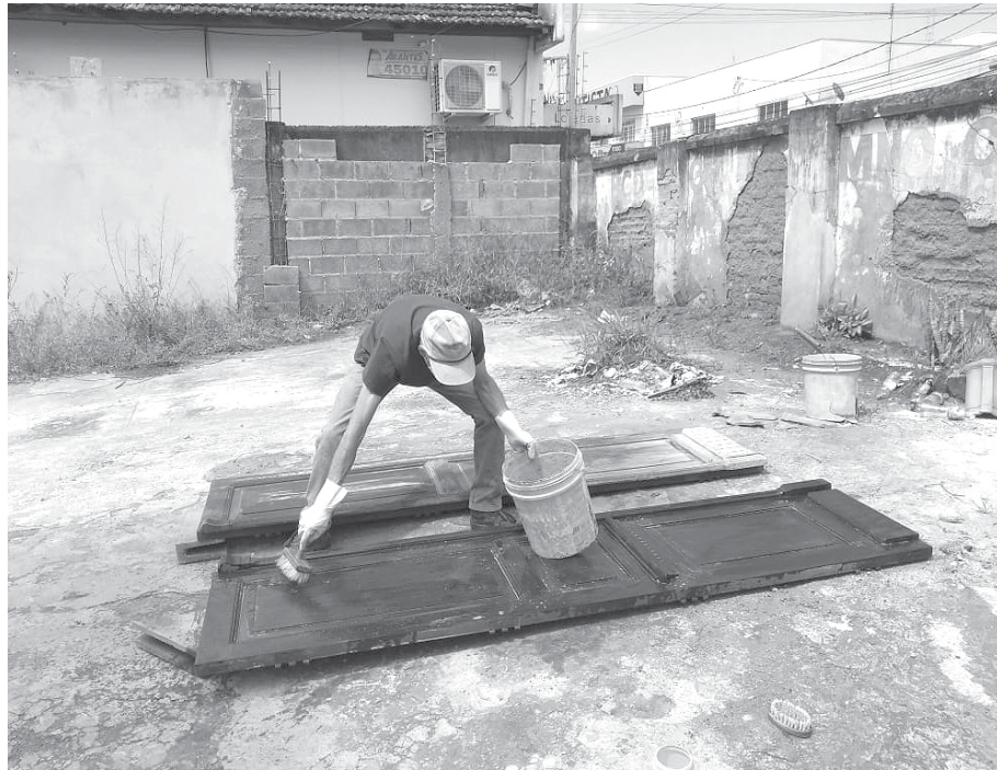
Restaurador paraense Jaime Carvalhais, está fazendo a restauração de partes da porta de madeira jatobá, da principal entrada no prédio do Instituto Monsenhor Felipe
