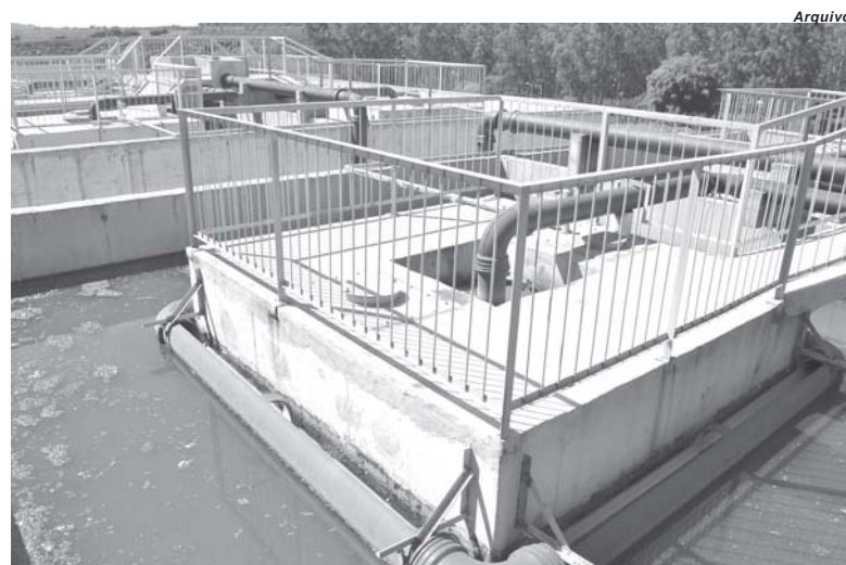
Cobrança pela coleta e tratamento do esgoto gerou polêmica e motivou ameaça de rompimento do contrato entre Município e a Copasa
