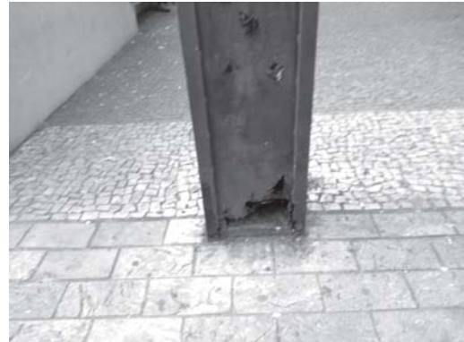
Postes de ferro com luminárias no calçadão da Praça Com. José Honório, centro, estão com as estruturas enferrujadas e corroídas, oferecem risco a segurança dos pedestres
