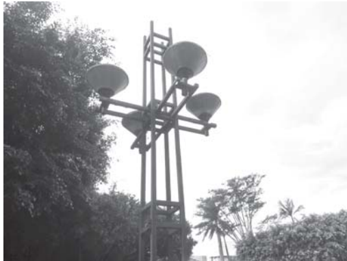
Postes de ferro com luminárias no calçadão da Praça Com. José Honório, centro, estão com as estruturas enferrujadas e corroídas, oferecem risco a segurança dos pedestres
