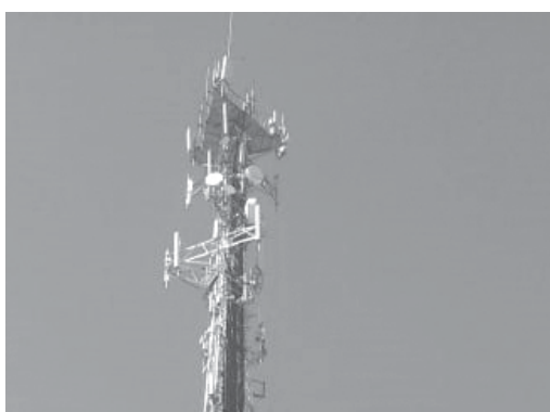
Torre de Telefonia Celular que fica localizada na Rua Espanha no Jardim Europa, a lâmpada de alerta de cor vermelha não acende durante a noite
