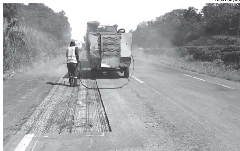
Funcionários da EPR Vias do Café realizam limpeza de caixa de freSa na rodovia
