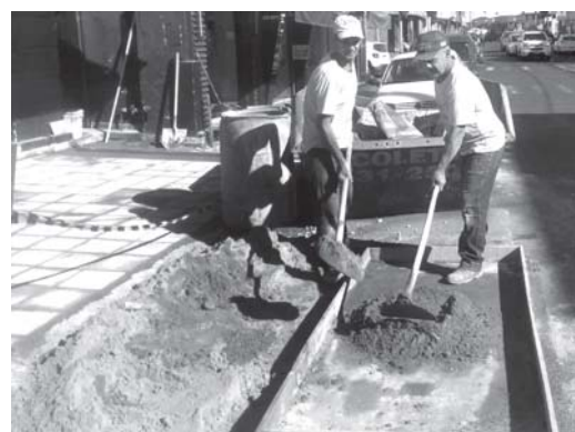
Os pedreiros Delson Batista e Joaquim Pereira, fazendo massa de cimento com areia dentro da caixa de madeira e uma das vias públicas de Paraíso
