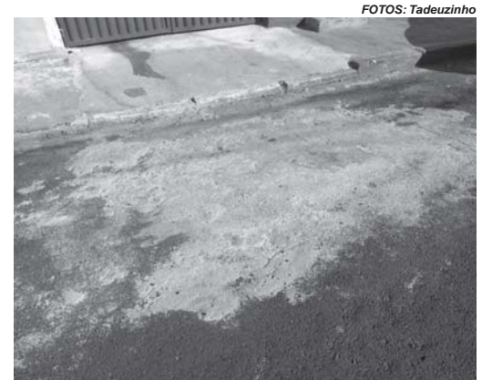
Em outro local da cidade, massa deixou asfalto com manchas, crostas de resto de massas
