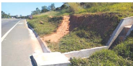
Região registrou aumento da densidade populacional ampliando volume de pessoas que precisam atravessar a rodovia
