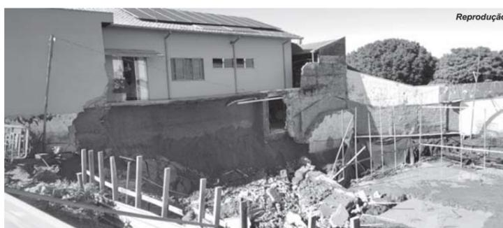
colapso do muro causou impactos na fundação da residência afetada, o que poderá comprometer sua estabilidade. Embora os danos não tenham sido generalizados, há indícios de que a estrutura do imóvel foi afetada, exigindo estudos técnicos detalhados para uma avaliação conclusiva.
