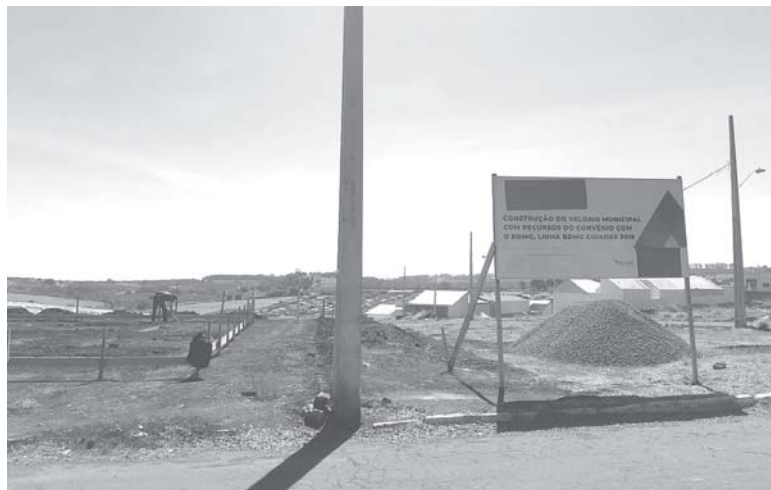
Ao lado do Cemitério Municipal construção do Velório
