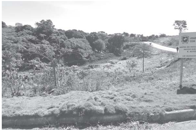
Canalização do Córrego Fortaleza Bairro Rosário
