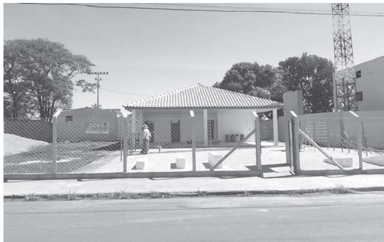
Construção da Academia da Saúde
