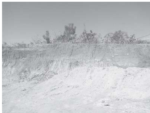
Sem autorização da Prefeitura, retiraram irregularmente uma quantidade enorme de terras de uma área verde que pertence ao Patrimônio Público Municipal
