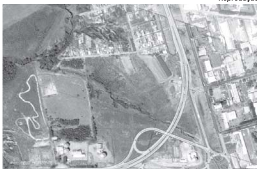
Interseção da MG-050 e BR-491 ganhou novo traçado para melhor fluência do trânsito e ligação entre bairros
