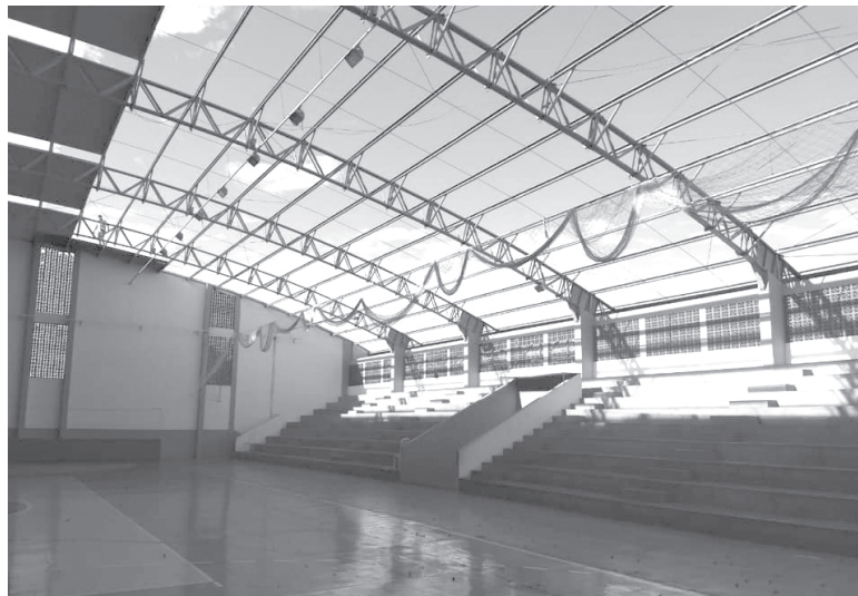
Poliesportivo já está destelhado para obras gerais de reforma e melhoramentos
