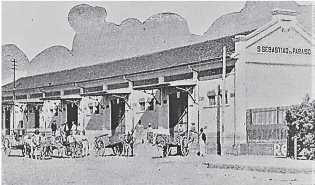
Estação da Estrada de Ferro Mogiana de São Sebastião do Paraíso. Fonte: Revista Sino Azul. Rio de Janeiro. Setembro de 1934
