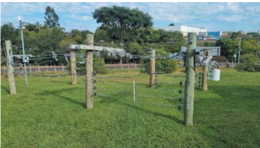
Área externa da unidade reproduz ambiente real de rede elétrica de média tensão, utilizada nos cursos voltados à elétrica industrial e predial, segurança em sistemas energéticos
