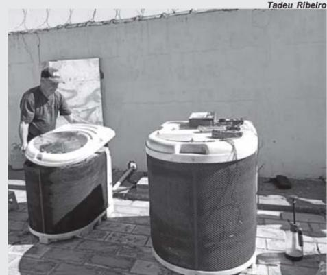
Técnico Márcio Luiz Zaquero realizando o concerto da máquina Trocador de Calor que vai aquecer as águas da Piscina do CSU 2
