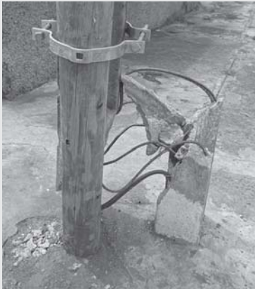
Poste quebrado e escorado com pedaço de poste de madeira, na Vila Formosa e resto de sujeira de terra deixado pela COPASA, na Av. Wenceslau Braz, Bairro Mocoquinha
