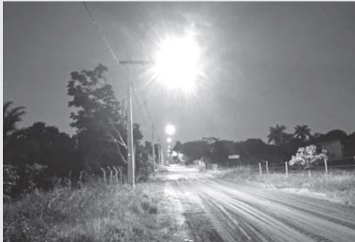
Moradores já providenciaram padrões, mas não conseguem instalar energia elétrica em suas casas
