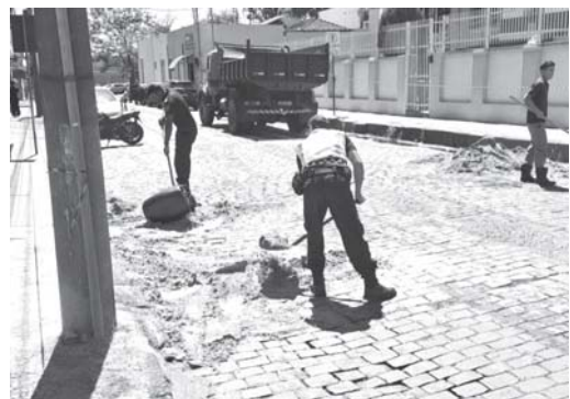
Equipes atuaram na contenção do produto químico com aplicação de areia e isolamento da área para garantir a segurança de pedestres e motoristas
